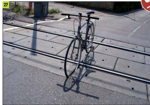
Photo 27 Écartement trop important entre les dalles (chutes par blocage de roue)
