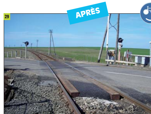
Joint en bois entre la voie et le bitume de la route en très mauvais état, sur une voie non perpendiculaire à la route (chute par glissade due au bois mouillé et blocage de roue).
