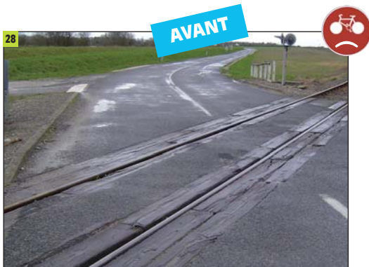
Joint en bois entre la voie et le bitume de la route en très mauvais état, sur une voie non perpendiculaire à la route (chute par glissade due au bois mouillé et blocage de roue).
